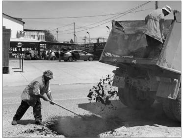
Ямочный ремонт дороги – самый распространенный на сегодняшний день метод оперативного восстановления дорожного полотна. Технология его выполнения отработана годами. Сначала с поврежденного участка дороги рабочие убирают пыль, грязь и мусор. Затем аварийный участок фрезеруется до устранения
