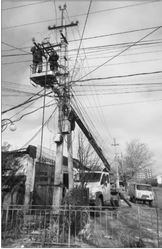
На улице Батырая специалисты провели плановые переключения абонентов для оптимизации схемы электроснабжения и перераспреде-
